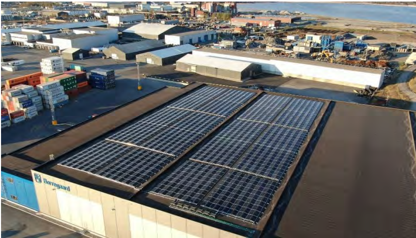
Figur 41: Solcelleanlegget på Borregaard-bygget i Borg havn. Samlet solcelleareal 4 400 m 2 . Foto: Borg havn
