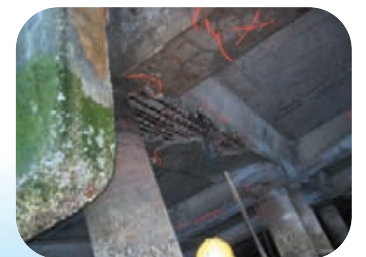
Reparasjon av betongskade.
